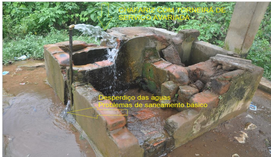
Figura 11. Torneiras estragadas de pontos de água nas aldeias Mateus e Kankenge, Uíge, (de Autor, 2023).
