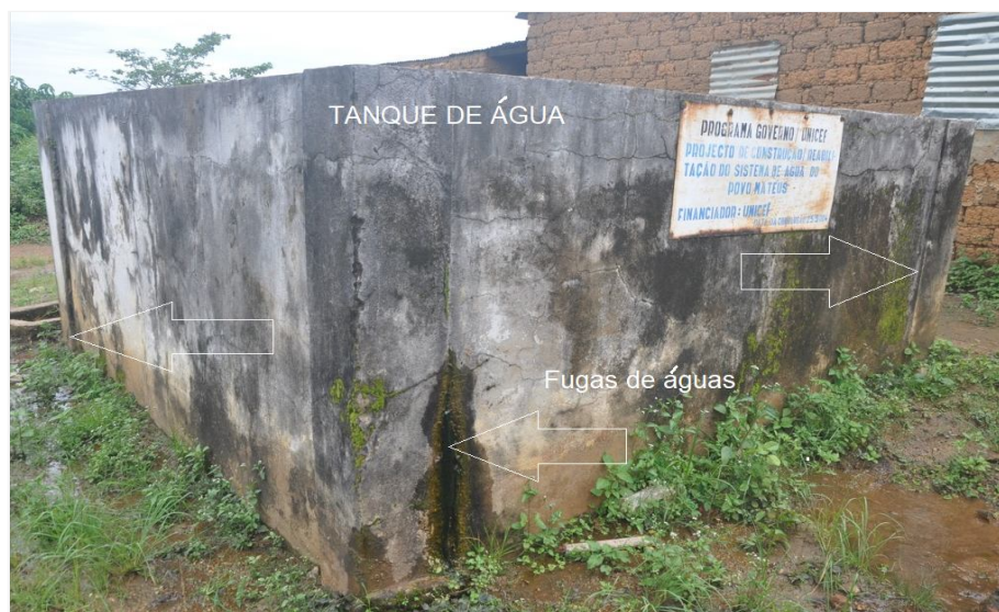
Figura 12. Tanque de chegada de água potável do Mateus em estado de insalubridade e degradação avançada, Uíge, (de Autor, 2023).
